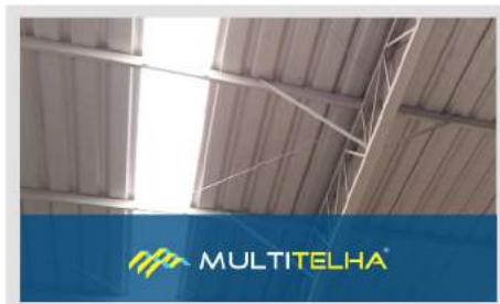
Telhas em policarbonato
